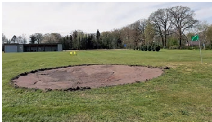
Driving-Range mit Watersplash im Bau.
