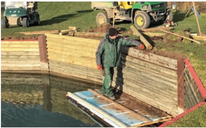
Die Holzbalken werden ausgetauscht.
