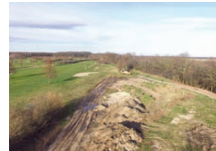
Die Bahn 15 wird verlängert, das Grün erhöht. Alles ist vorbereitet, im nächsten Jahr soll alles fertig sein.
