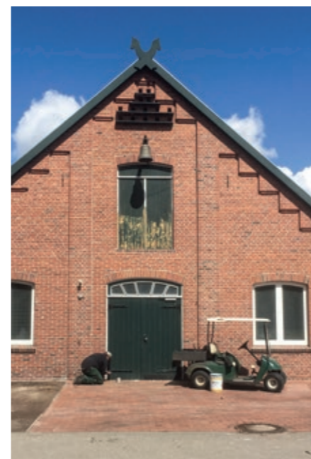
Frisch verfügt: Die Renovierungsarbeiten an der Frontpartie sind nahezu abgeschlossen. Die große Tür wird noch erneuert.
