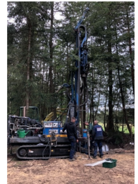
Die Bohrungen können beginnen.
