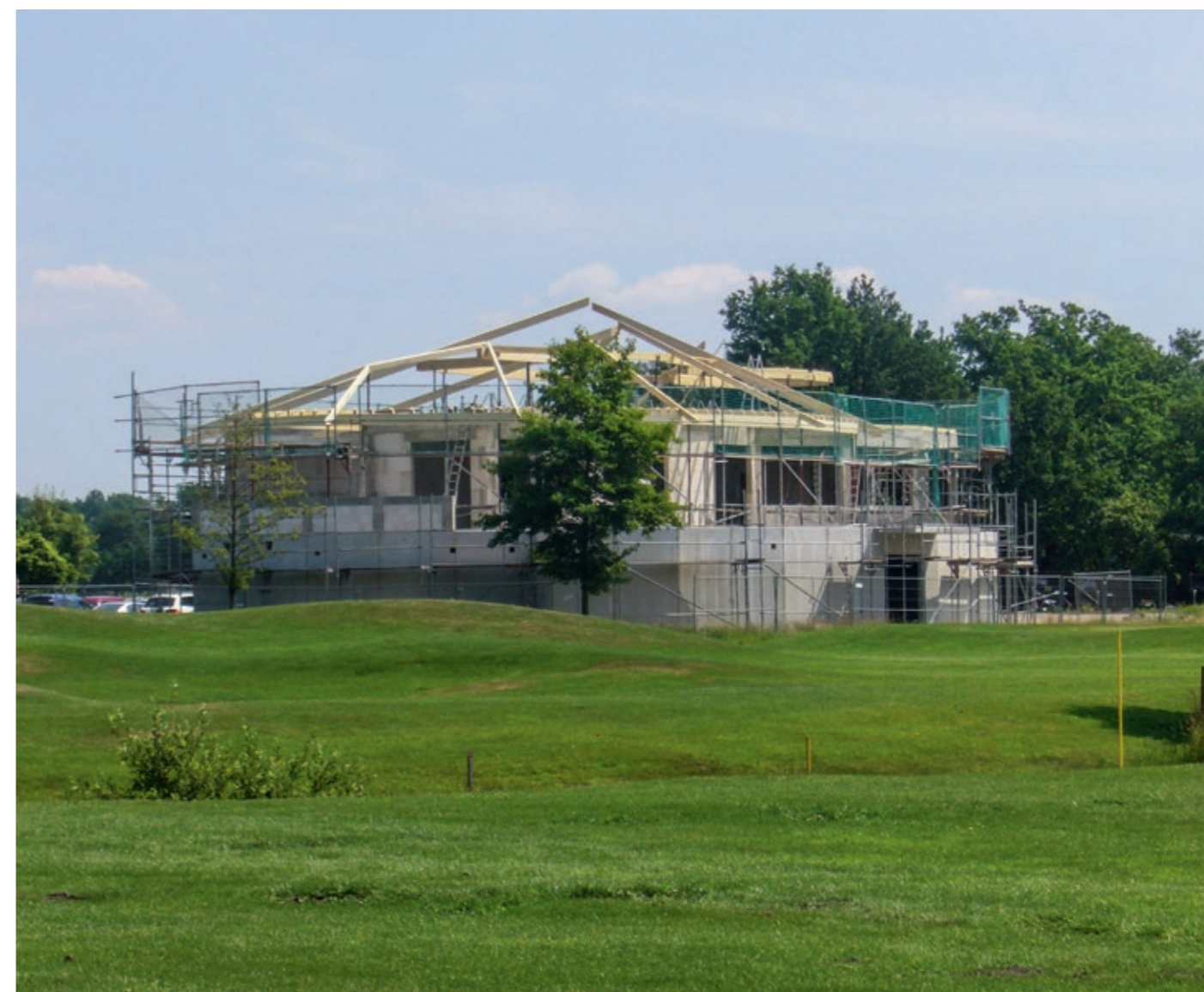
Das neue Clubhaus entsteht.
