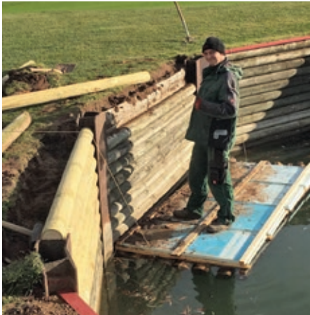
Die Holzbalken werden ausgetauscht.
