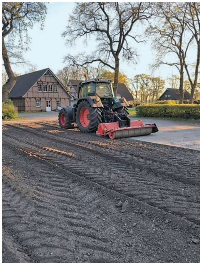
Greenkeeper Pascal bei der Sanierung des Parkplatzes.
