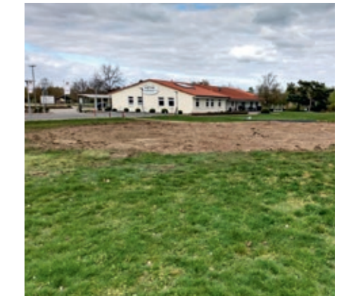
Die alte Caddyhalle wurde schon abgerissen. Der Club wartet auf die Baugenehmigung für das neue Gebäude.
