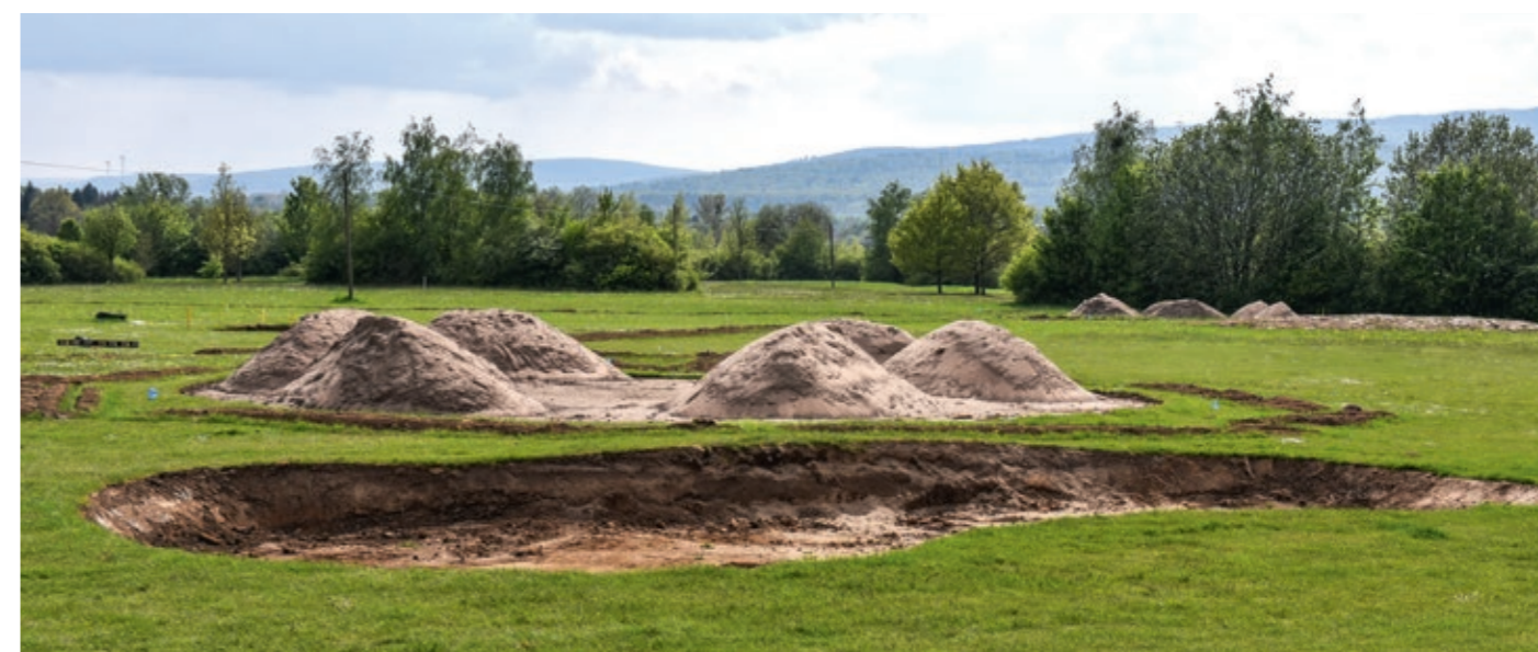
An der Baustelle für neue Übungsbahnen.
