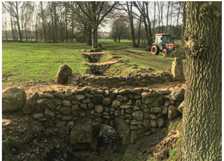
Neubau der Brücken an Bahn 11.
