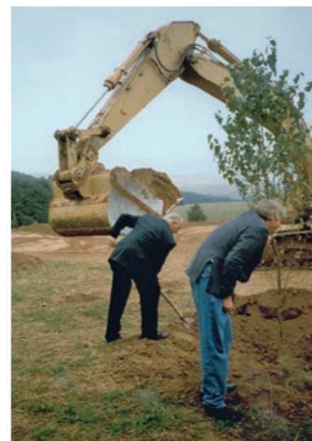
Der Golfplatzbau beginnt: Klaus Schulze Niehoff und Siegfried Obermann beim Spatenstich.
