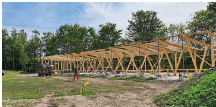
Ständerwerk an der Driving Range.
