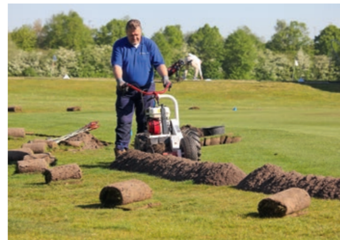
Erneuerung der Bewässerung des Übungsgrüns auf der Driving Range.
