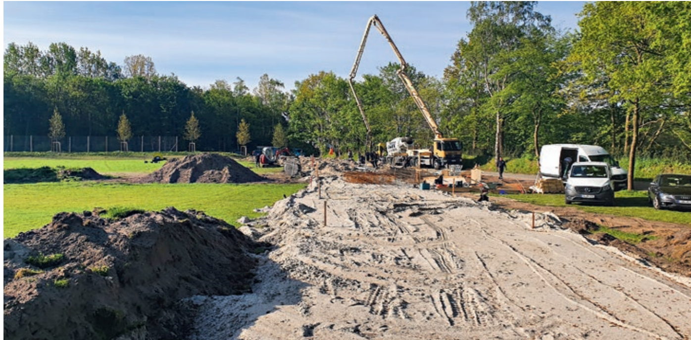
Betonarbeiten an der Driving Range.
