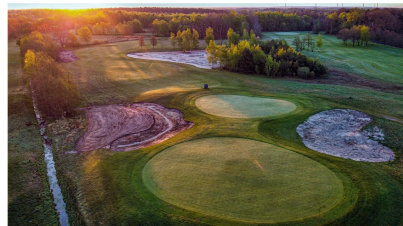
Am 30. April konnten die umfangreichen Bunkerrenovierungen erfolgreich abgeschlossen werden.
