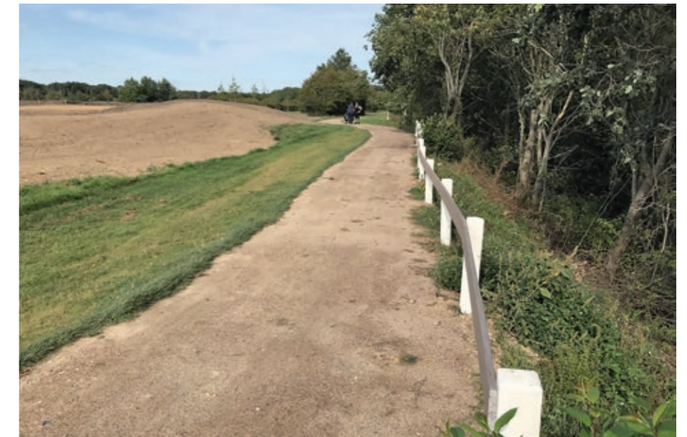
Sicherheit geht vor: Der Verbindungsweg von der Bahn 15 zur Bahn 16 wurde mit einem Zaun abgesichert.
