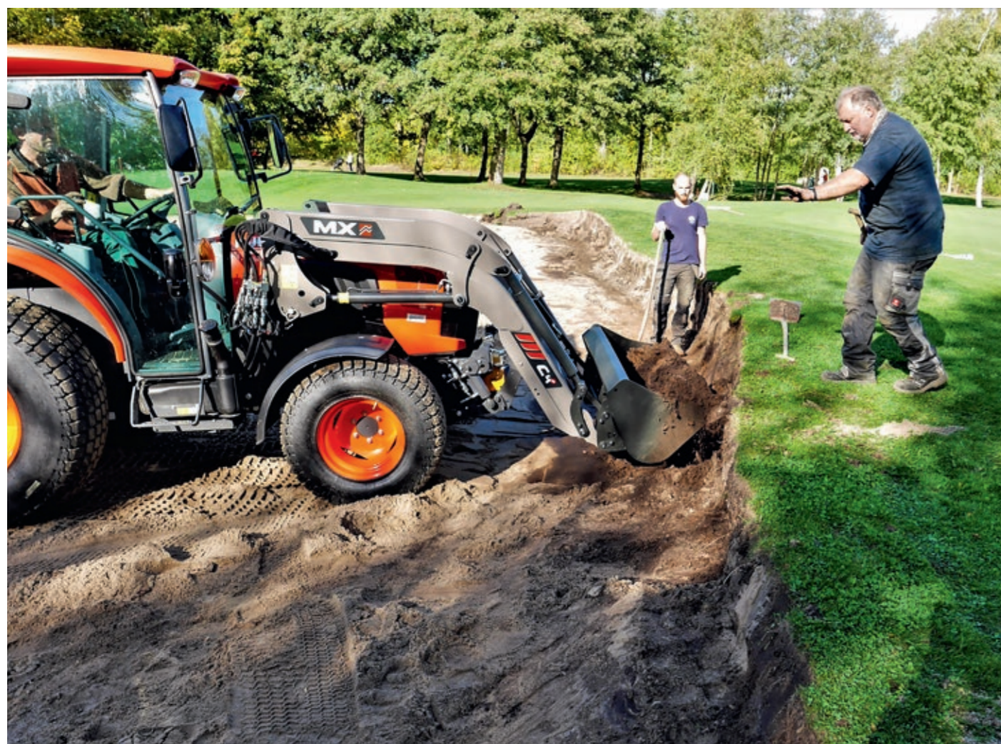
Vorbereitungen mit schwerem Gerät.
