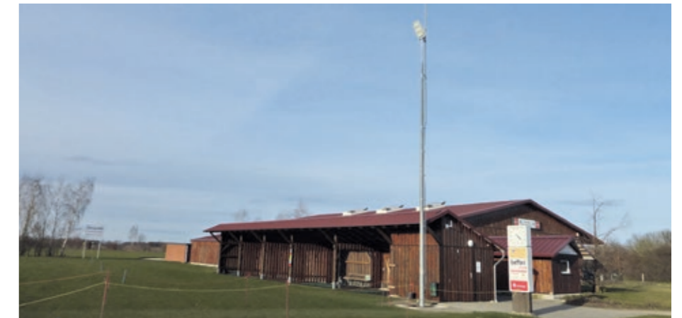
Am Übungsgelände kommt jetzt wieder der Flutlichtmast zum Einsatz.
